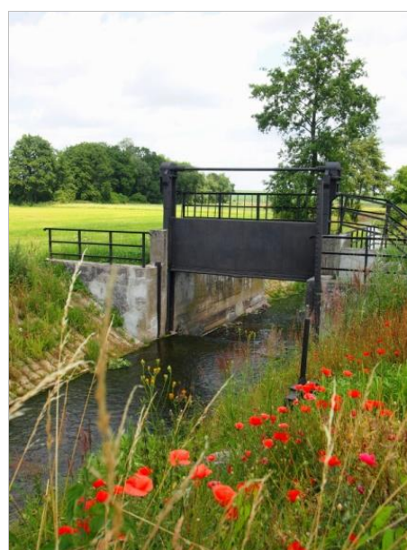
Jaz zastawkowy na Potoku Cisek (Jaborowice)
